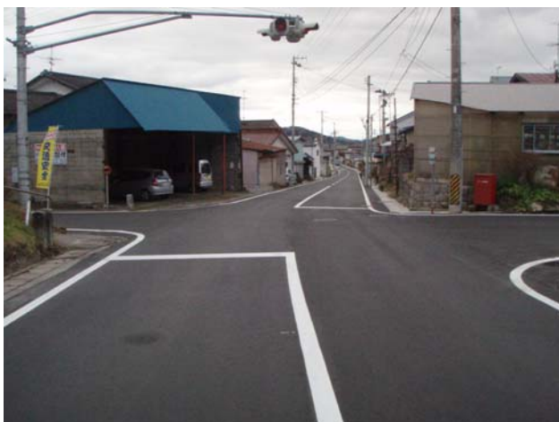
地方特定道路整備工事（竣工）
